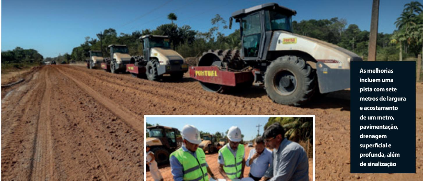
As melhorias incluem uma pista com sete metros de largura e acostamento de um metro, pavimentação, drenagem superficial e profunda, além de sinalização
