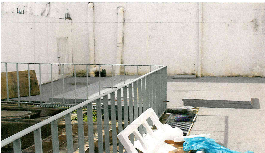
Imagem 4: Área onde está instalada a fossa que divide a área com o imóvel da Prodam. (Fonte da Imagem: Equipe técnica da PPIF/PGE)
