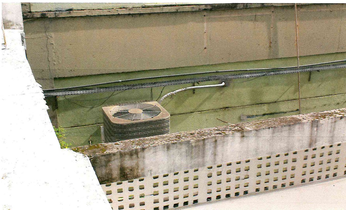
Imagem 8: Muro que divide a Prodam com a Estação de Tratamento de Esgoto. (Fonte da Imagem: Equipe técnica da PPIF/PGE)
