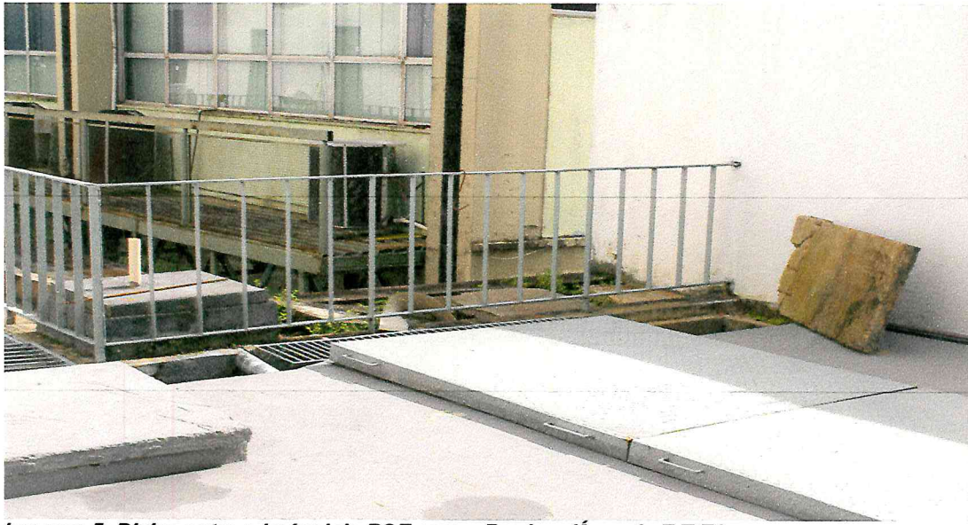
Imagem 5: Divisa entre o imóvel da PGE com a Prodam (Área da E.T.E.) (Fonte da Imagem: Equipe técnica da PPIF/PGE)
