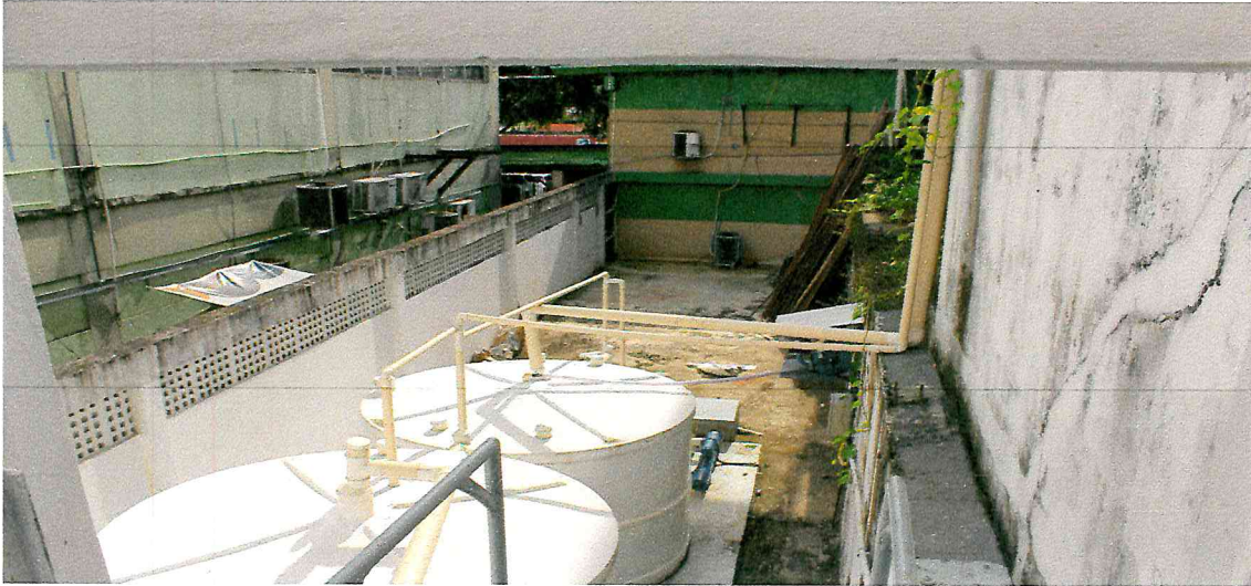
Imagem 9: Vista da E.T.E., tirada de frente para o fundo da Prodam. (Fonte da Imagem: Equipe técnica da PPIF/PGE)
