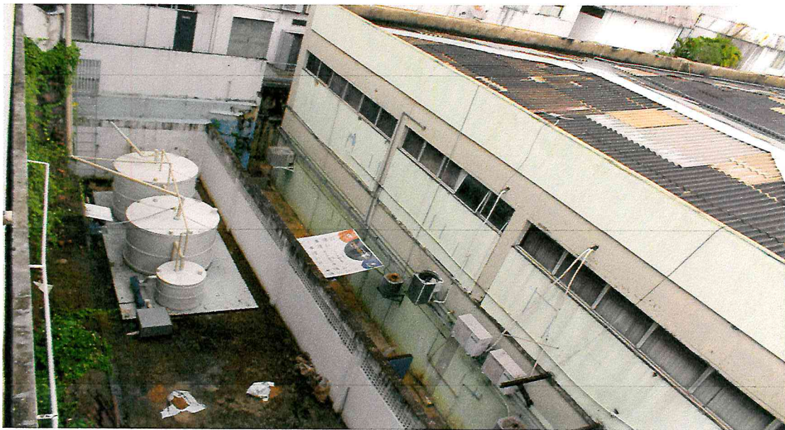
Imagem 10: Vista geral da E.T.E. com o limite sul do imóvel Prodam. (Fonte da Imagem: Equipe técnica da PPIF/PGE)
